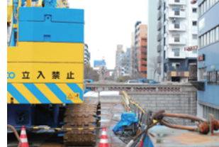
屋内外の建築土木
