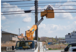
炎天下の高所作業
